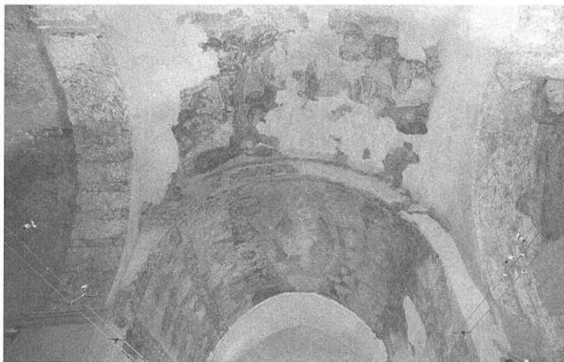
Aspecte general de la volta, un cop descobertes les pintures.
